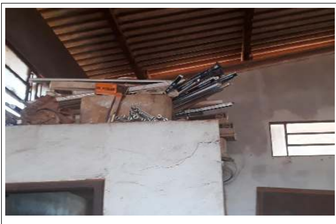
Figura 66: Acondicionamento de resíduos de lâmpadas queimadas no pátio da Secretaria de Agricultura da Prefeitura Municipal de Boa Vista da Aparecida/PR Fonte: Elaborado pelo autor, 2019.
