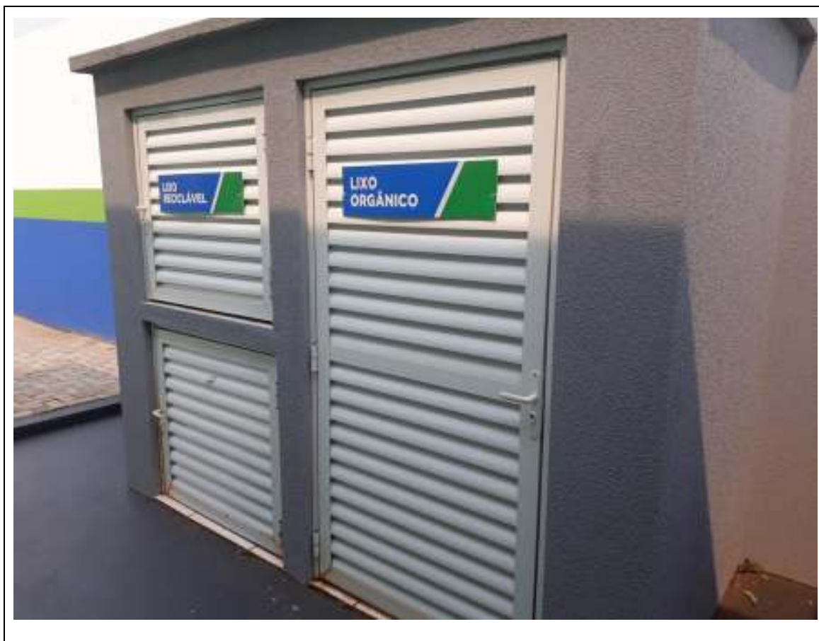
Figura 53: Edificação específica de armazenamento temporário de resíduos dos serviços de saúde da UBS Severino Bett do município de Boa Vista da Aparecida/PR Fonte: Elaborado pelo autor, 2019.
