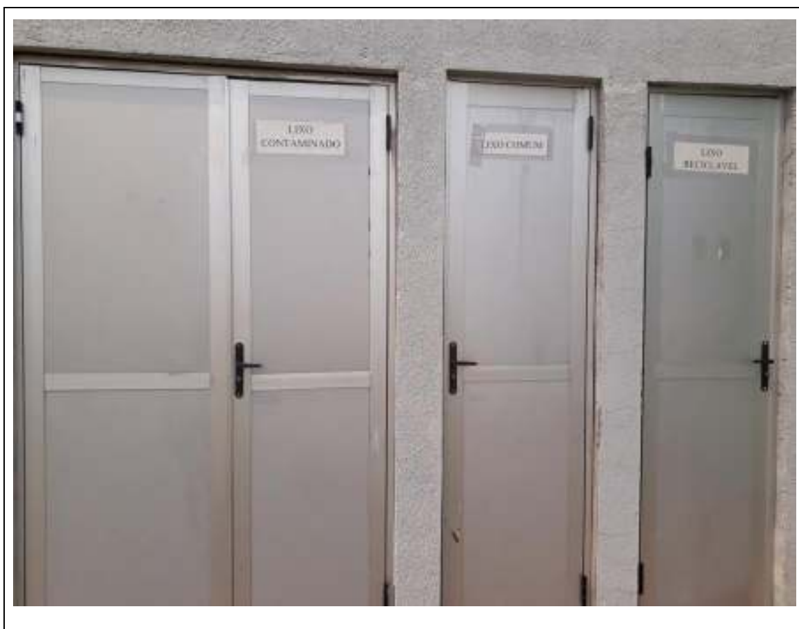
Figura 49: Edificação específica de armazenamento temporário de resíduos dos serviços de saúde da UBS José Carlos Henrichs do município de Boa Vista da Aparecida/PR
