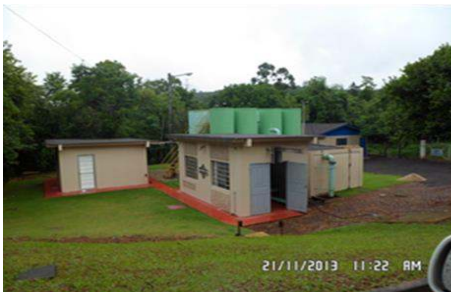
Figura 14: Reservatório de 25 m 3 no pátio da Estação de Tratamento de Água Fonte: SANEPAR, 2013.
