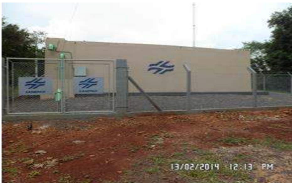
Figura 15: Reservatório de 500 m 3 na Rua Primo Marcon. Fonte: SANEPAR, 2014.
